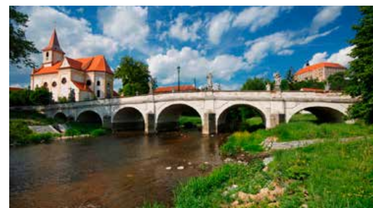
Řeku překlenuje barokní most se sochami světců (foto: Jiří Polehla)
